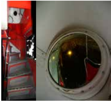
Escalier vers le niveau supérieur. Le miroir laisse voir l'installation dans la lumière jaune.
